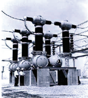
Resim 23.9 Basınçlı hava üflemleri kesici
