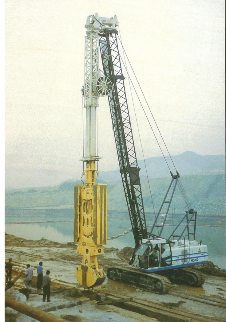
DİYAFRAM DUVAR VE ANKRAJLI İKSA SİSTEMİ
